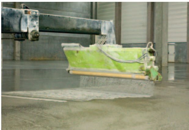
Couche d'usure incorporée, saupoudrage mécanique.
