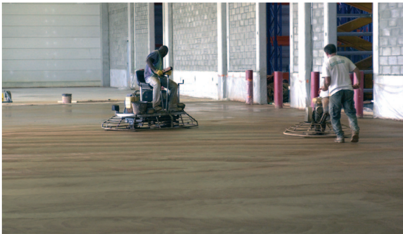
Le couche d'usure est incorporée par lissage mécanique à l'hélicoptère birotor ou monorotor.
